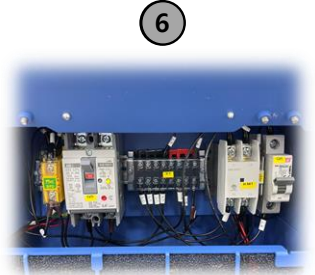
공정 : 차단 스위치 ON (Q5, Q6) 스위치가 올라가면 ON 상태
