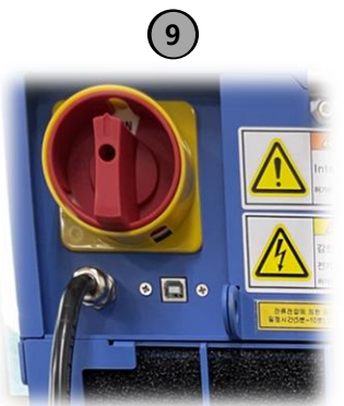
공정 : LOTO 잠금 해제 및 메인 전원 스위치 ON
